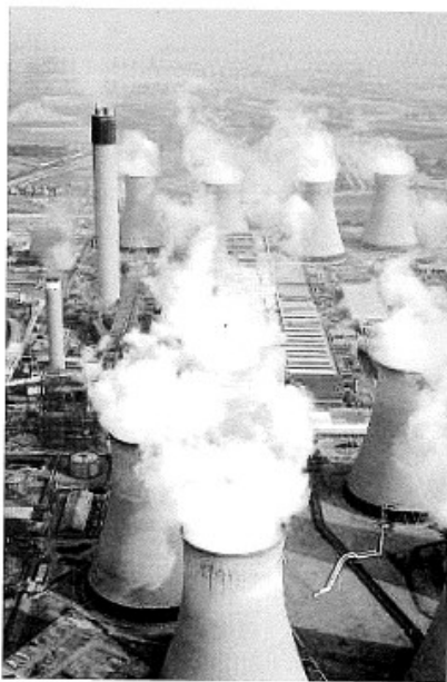
Una centrale nucleare; a sinistra, Maniglio
